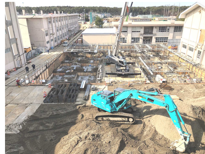
③ 教室・特別・管理棟建設地
